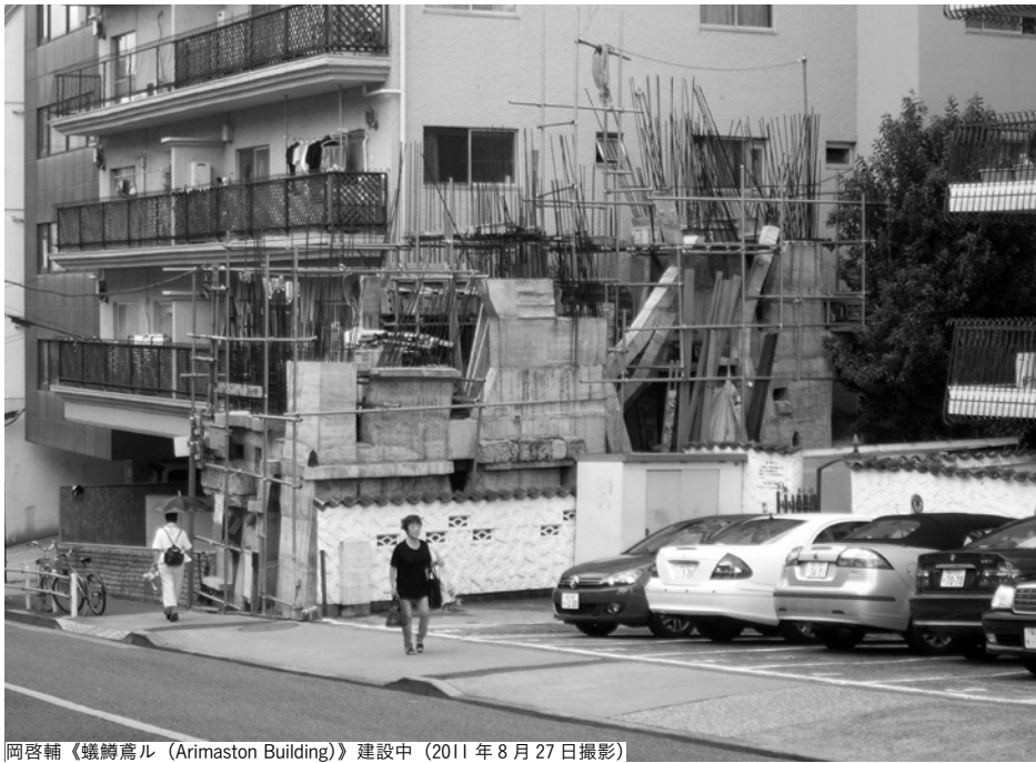
岡啓輔《蟻罎鳶ル (Arimaston Building)》建設中 (2011年8月27日撮影)
